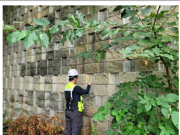
경사계를 이용한 경사도 측정
