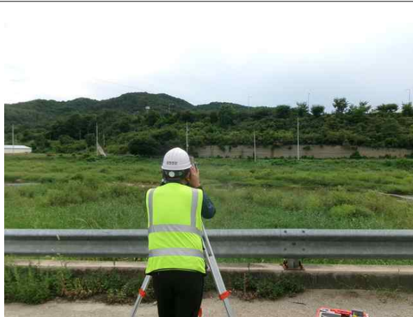
광파기를 이용한 측량 작업
